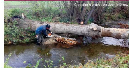
Chantier d'entretien des rivières.
