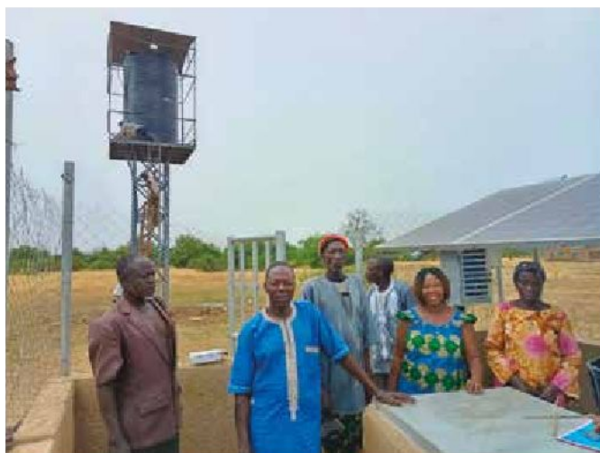
Château d'eau à Didyr au Burkina Faso
